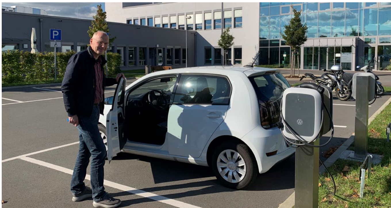
Wir haben schon Ladestationen für E-Autos
